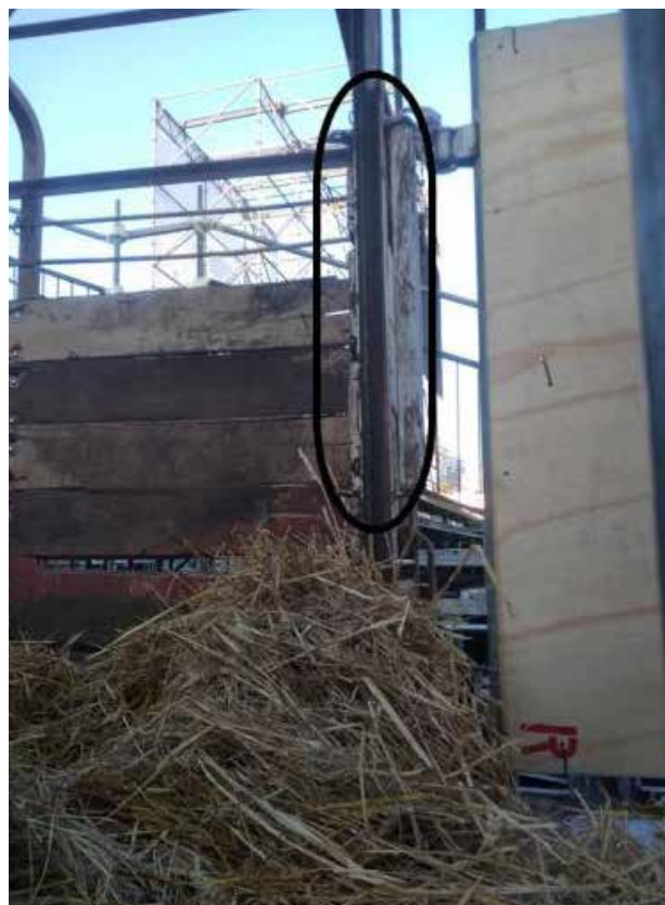
Figura 11. Presencia sólo del rodillo giratorio externo, pero falta el interno. Inadecuado según la Resolución SENASA 557/2024.
