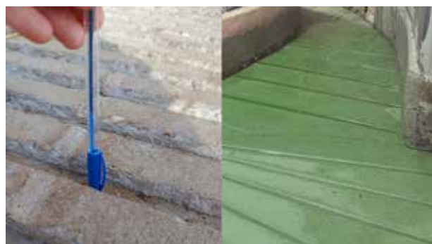
Figura 1. Piso en corrales y pasillos de hormigón ranurado.
